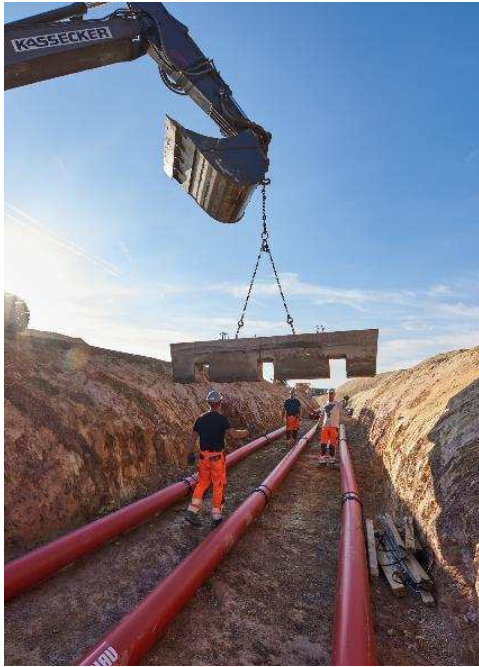
TIEF- UND ROHRLEITUNGSBAU
